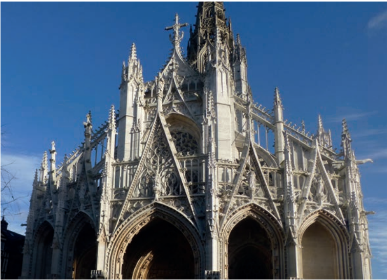
La toiture et la façade restaurées de l'église Saint-Maclou de Rouen, chef-d'œuvre du gothique flamboyant. © Photographie Jacques Calu, 2015.
