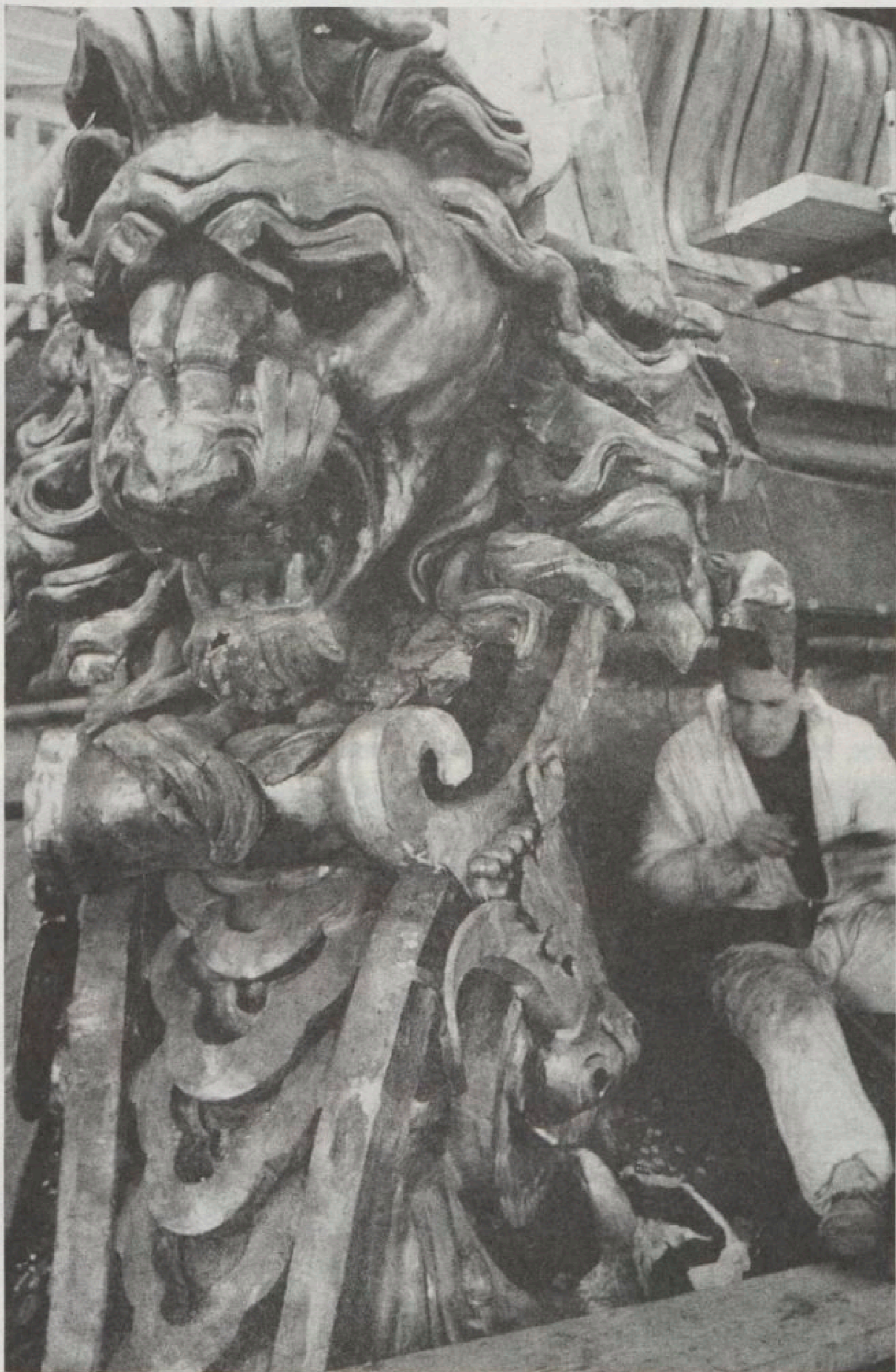
Ornementation toiture - Pavillon Denon.
