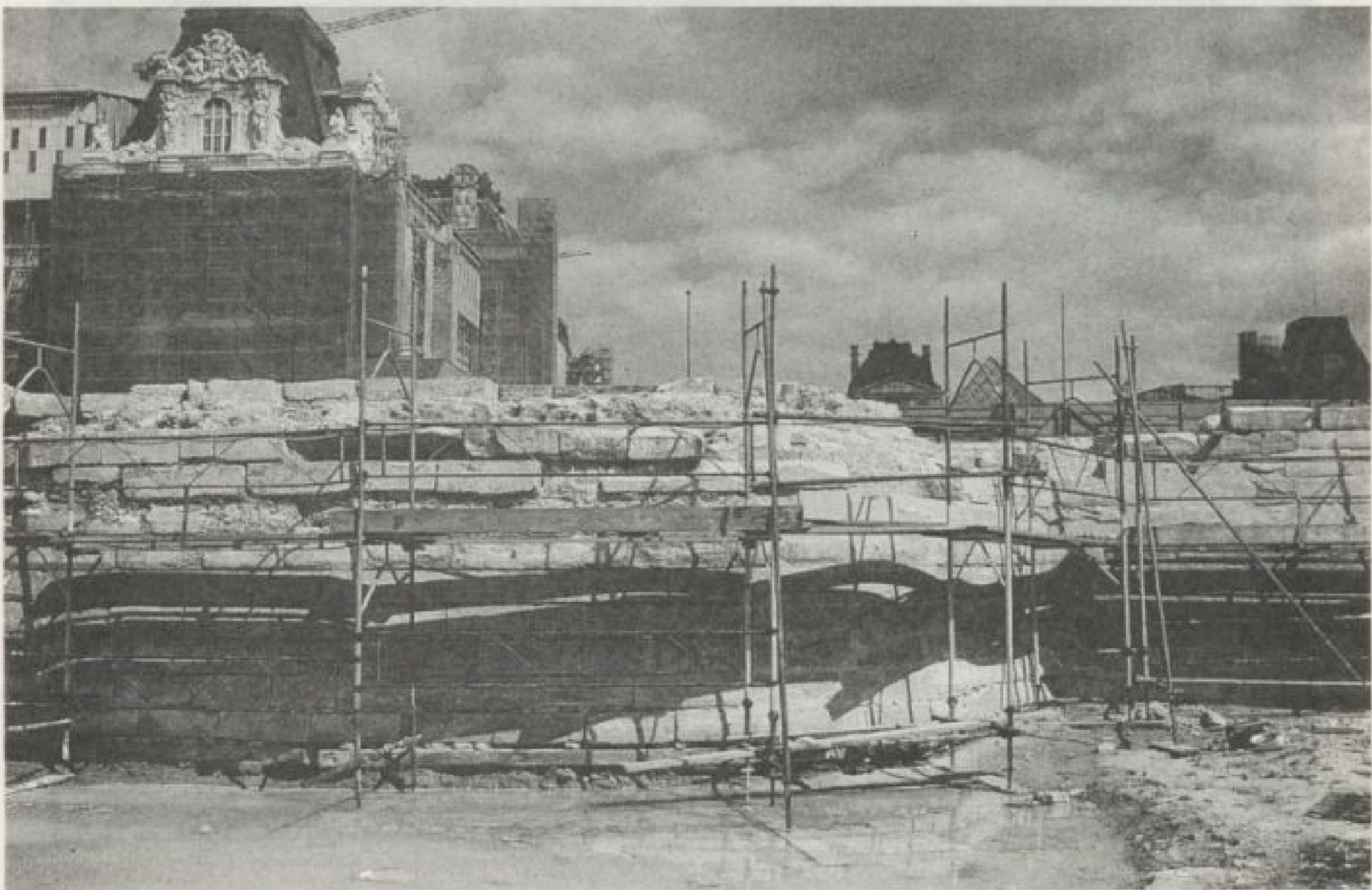
Mise à jour du fossé Charles V.
